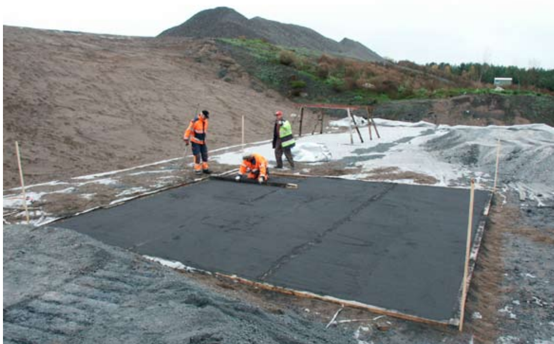
Figur 28. Installation av den nedre elektroden i ytan längst upp till vänster i Figur 27.
