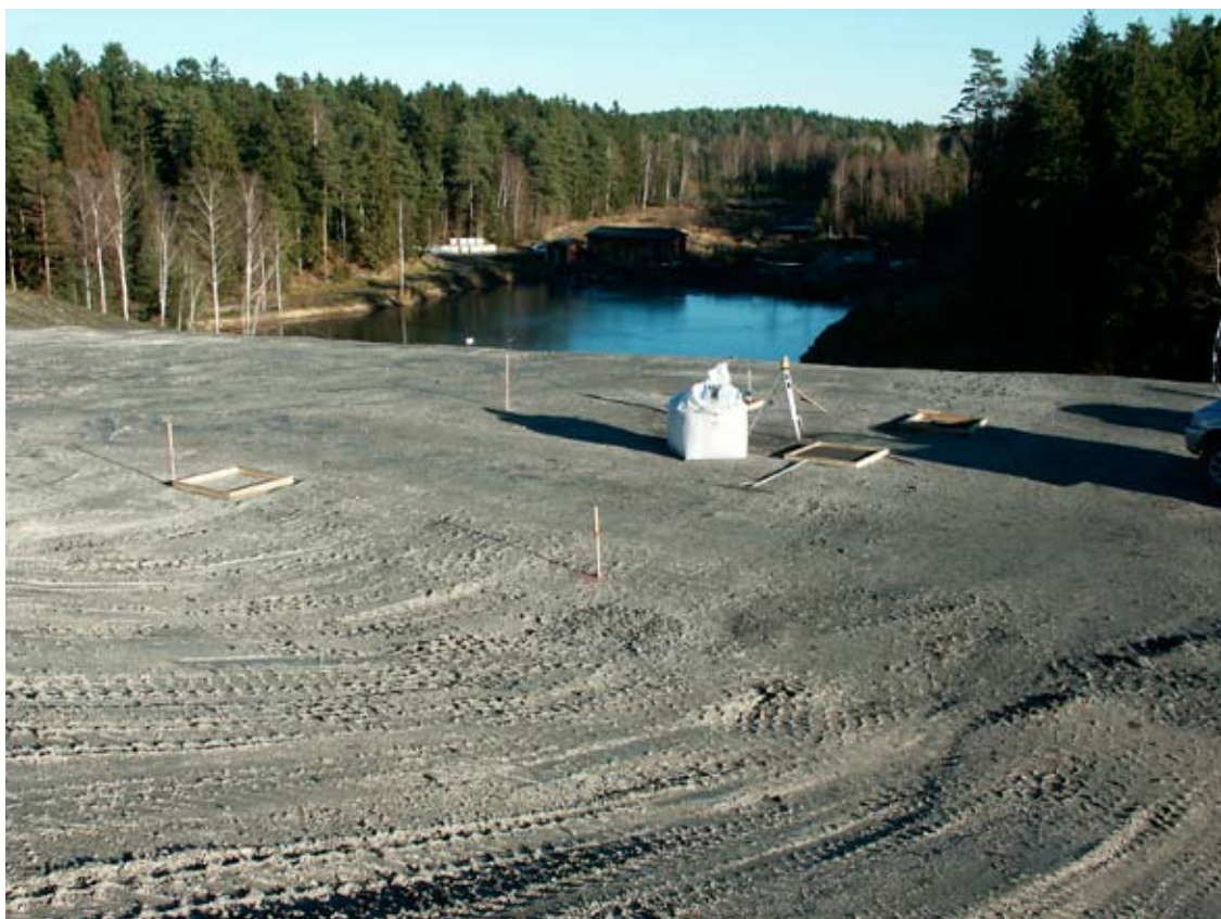
Figur 30. Installation av elektroderna på mellannivå. De skall förses med hyttsot från storsäcken samt kopparplatta med tillhörande koaxialkabel enligt Figur 31.
