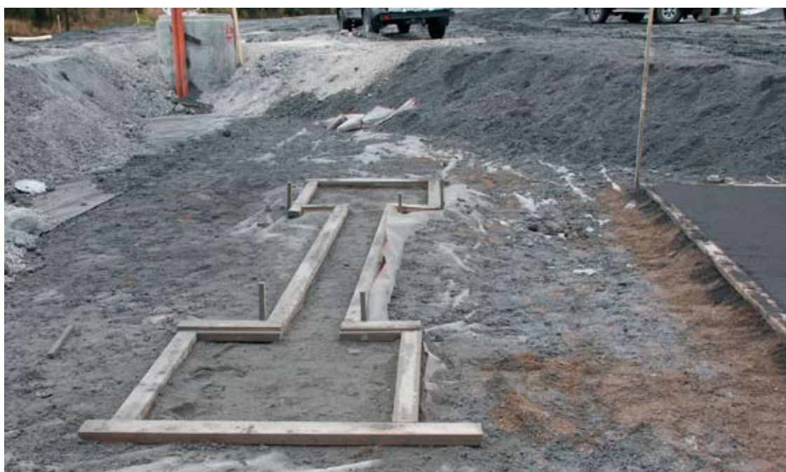
Figur 29. Installation av den nedre elektroden i ytan längst upp till höger i Figur 27. Till höger i figuren ses en del av elektroden i Figur 28.
