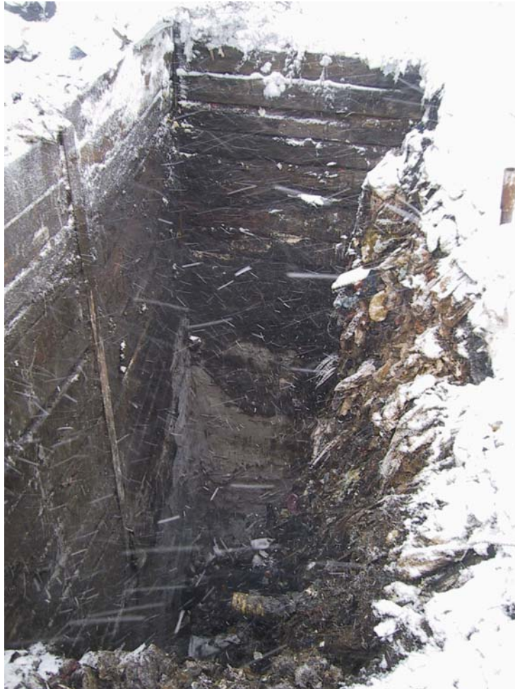
Figur 65. Injekterad aska i ena hörnet av testcellen med organiskt avfall.
