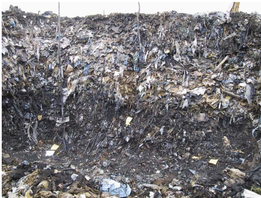
Figur 61. Utgrävt schakt framför hål 3, 4 och 15 ner till 5,5-6 meters djup.
