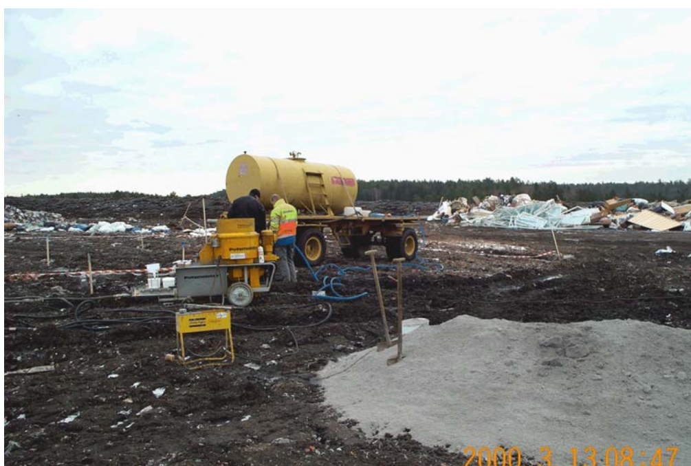
Figur 2. Vattentank, injekteringsutrustning (blandningstank, pump och injekteringsslang) samt färsk flygaska för injektering. Injekteringsutrustningen är den mindre utrustningen vilken provades under de två första injekteringsdagarna.
