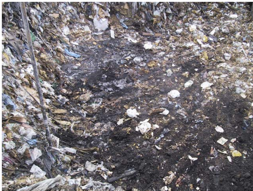
Figur 58. Schaktet ovanifrån vid 4,5 meters djup där ett lager av gjuterisand finns. Lite klumpar av injekterad aska kan ses mitt i schaktet framför hål 4.
