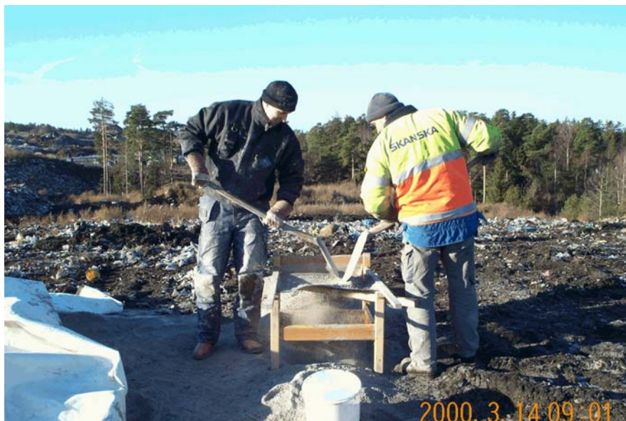
Figur 39. Siktning av flygaska till >2 mm under den första injekteringsdagen 4/11 2002.
