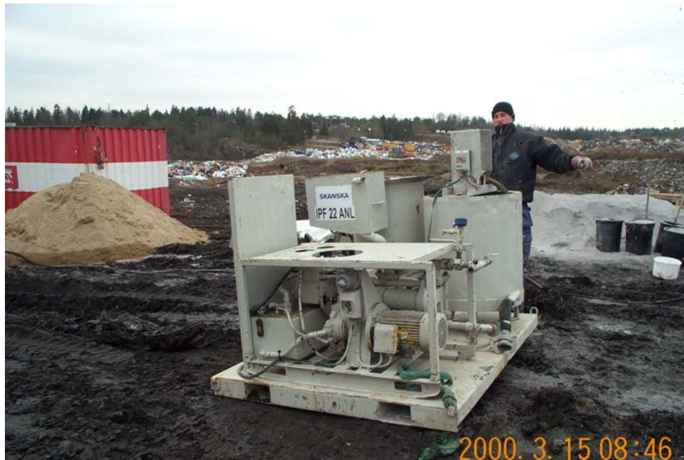
Figur 12. Utrustningen för cirka 150 liter som användes under större delen av injekteringsarbetet (pumpplattform Willisich).
