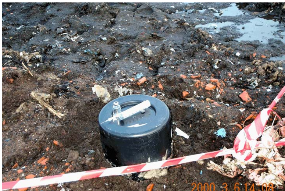
Figur 47. Utrustingen (hink, spruta och glasflaska) som användes för gasprovtagningen på deponin före injekteringen.
